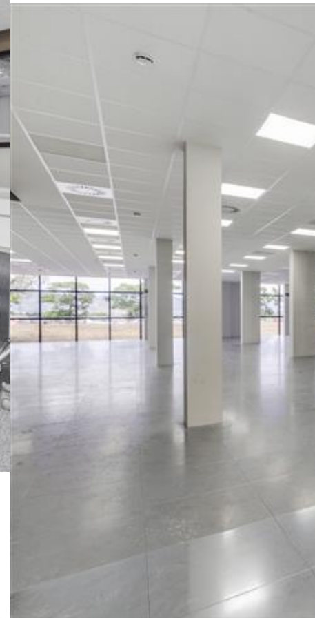
Falso techo registrable 60x60cm Iluminación LED
