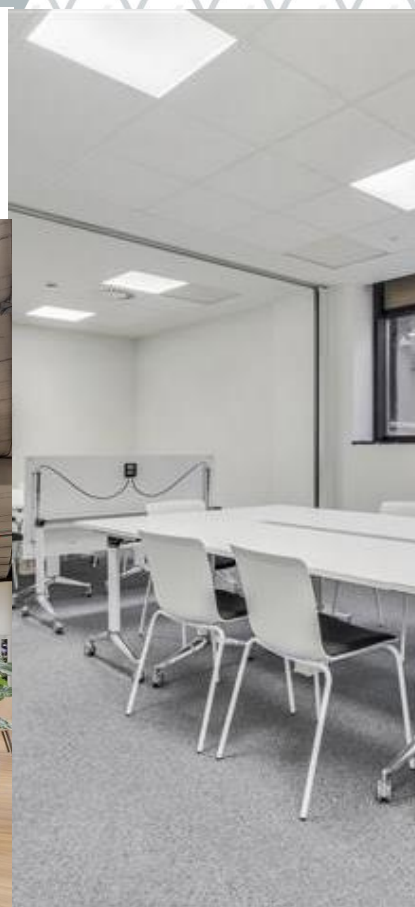
Falso techo registrable 60x60cm Iluminación LED
